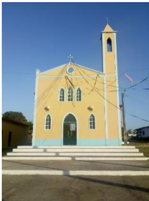
Figura 3 Fachada da Igreja de Nossa Senhora das Graças. Fonte: A autora
