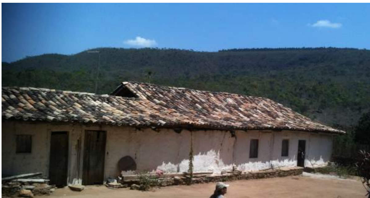
Foto 1: Casarão da Fazenda Alto dos Bois, datado de 1729. . Autor: Trigueiro, 2014.
