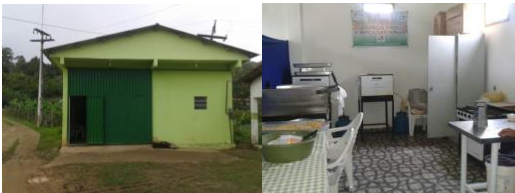
Figura 3. Galpão na comunidade do Baixão
