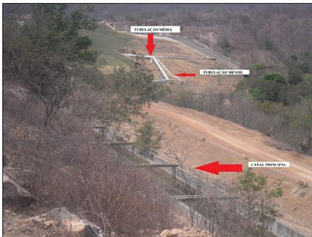
Figura 2 – Visualização do canal principal do projeto Gorutuba e das tubulações de fornecimento de água para usos múltiplos na Barragem Bico da Pedra.
