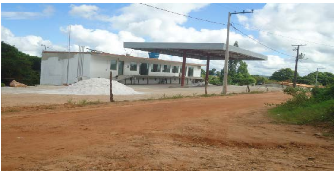
Figura 01- Construção de auto posto de combustíveis no meio rural sergipano. Fonte: Nascimento, J. & Mendes (2016)a.
