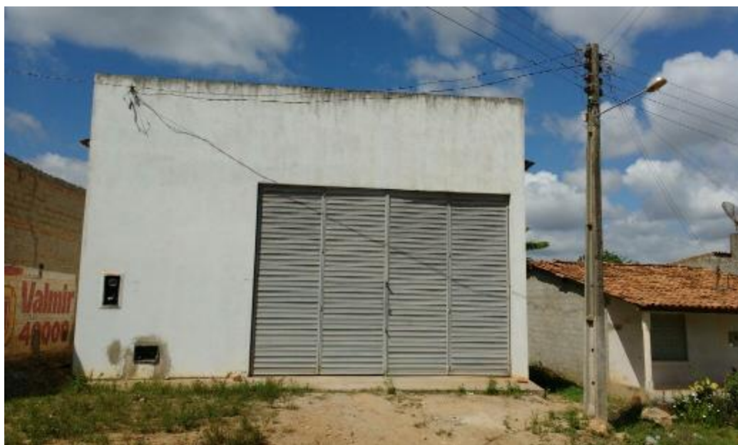
Figura 02: Armazém Comunitário no Povoado Mangabeira. Fonte: Trabalho de campo CMDS, Junho de 2016.
