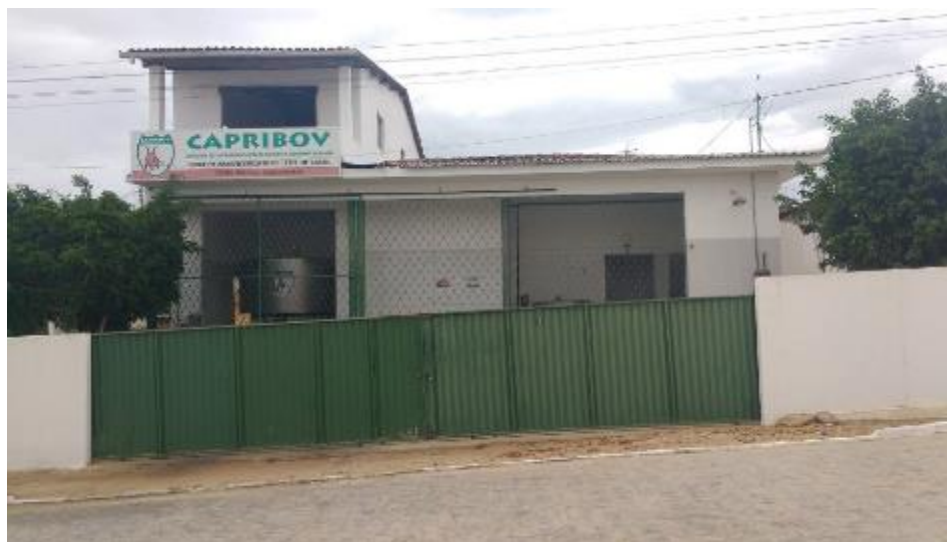
Fotografia 01 – Fachada da CAPRIBOV, no município de Cabaceiras - PB
