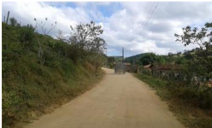
Figura 3- Rua sem calçamento no Distrito de Moçambo. Fonte: Letícia Almeida Araújo, 2016. Pesquisa de campo. (maio, 2016).
