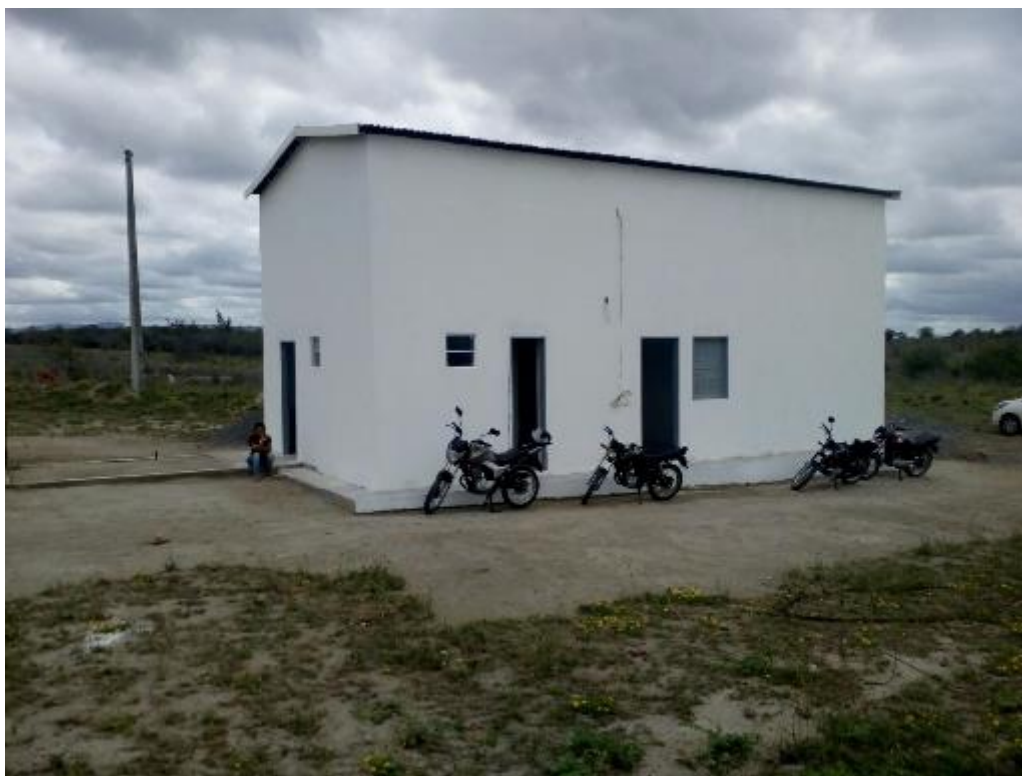
Figura 4 – Vista externa do abatedouro do Alto do São Gonçalo em Itiúba-BA.
