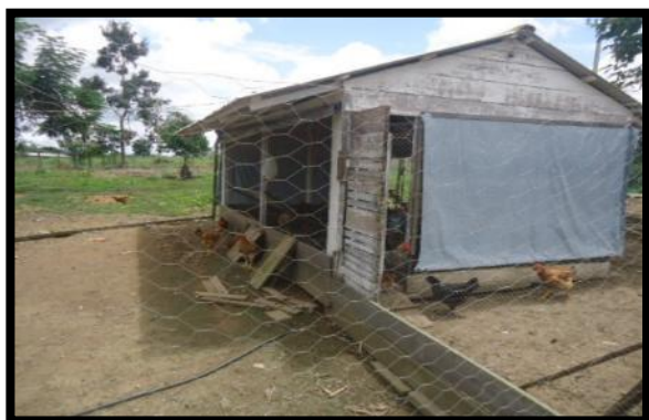
Figura 03: galinheiro construído pela Norte energia. Fonte: GEDTAM
