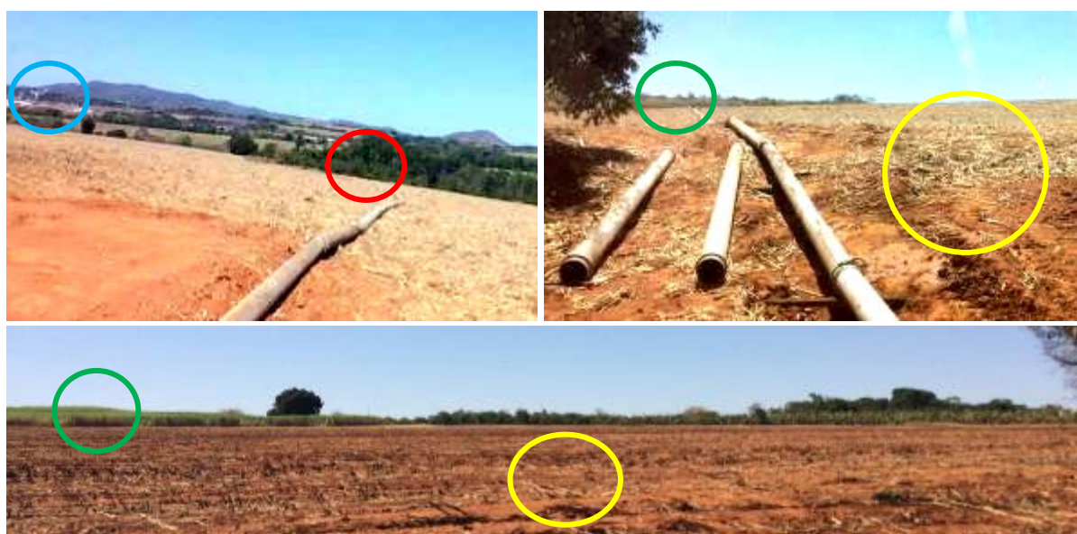
Figura 06: Imagens da instalação de infraestrutura para extração de água do rio Uru para irrigação do cultivo de cana-de-açúcar
