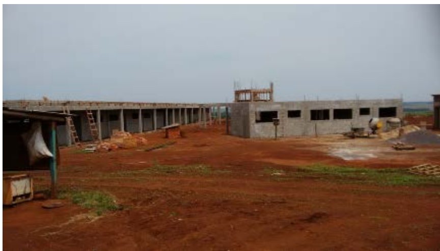
Figura 03 Construção do Novo Colégio Estadual do Campo Aprendendo Com a Terra e Com a Vida.
