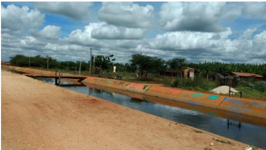
Figura 05. Canal de adução de águas do rio Jaguaribe para as áreas agrícolas da Chapada do Apodi. Foto: autora, 2017
