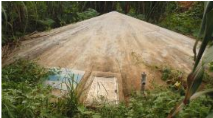
Figura 2 – Cisterna de enxurrada. Fonte: PAULO, S. B (2015).
