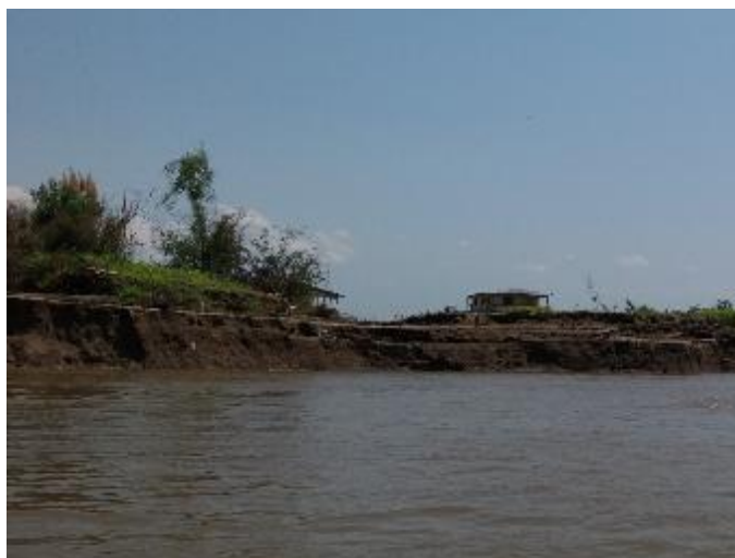
Figura 2 – Margem do Rio Solimões atingida pelas Terras Caídas; em segundo plano moradias em situação iminente de desabamento. Autor: Ana Paulina Aguiar Soares.
